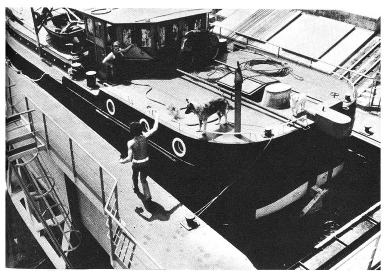
Die ungewöhnliche Querfahrt in der gigantischen «Badewanne» ist auch für die Schiffer immer wieder ein Erlebnis. Zwischen der Bedienungszentrale und dem Rolltrog besteht eine Lautsprecherverbindung. Für alle Phasen des ungewöhnlichen Schiffstransports sind zahlreiche Sicherheitsvorrichtungen im Einsatz.
