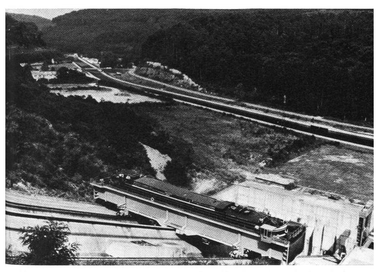
Vom unteren Anschlussbauwerk fährt das Schiff in einem Bogen in den talseitigen Kanal Richtung Strassburg ein. In der linken oberen Bildecke liegt die Abzweigung des alten Kanals, der parallel zur Eisenbahnlinie Strassburg-Paris nach links in das kleine Teigelbachtal einbiegt, durch das die Schleusentreppe von Arzviller führt.
