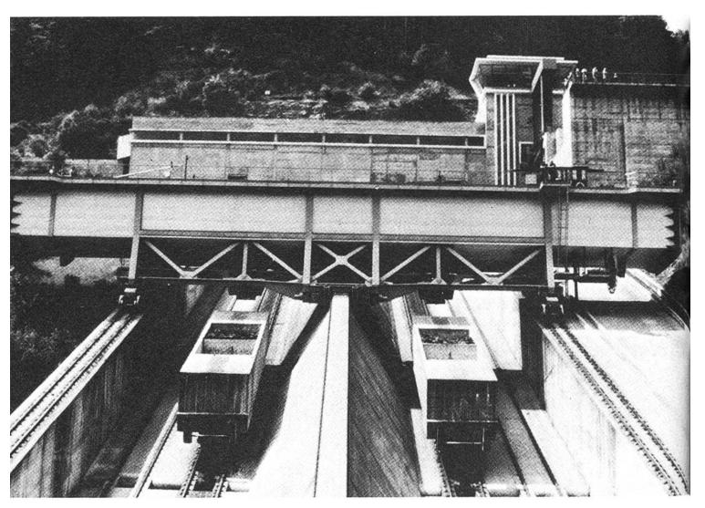
Durch zwei ihrerseits auf Schienen fahrende Gegengewichte wird der Rolltrog genau ausgewogen. Das System befindet sich damit stets im Gleichgewicht, weshalb zur Beförderung der Schiffe die überraschend geringe Antriebsleistung von zwei Elektromotoren zu je 125 PS ausreicht.
