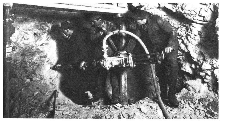
Bei den Bohrarbeiten für die Jungfraubahn, die eine Gesamtlänge von 9336 Meter aufweist, wovon 7122 Meter (langer Tunnel), 110 Meter (kurzer Tunnel) und 230 Meter (Galerie) unterirdisch sind, wurden immer wieder neue Pionierleistungen erbracht.
