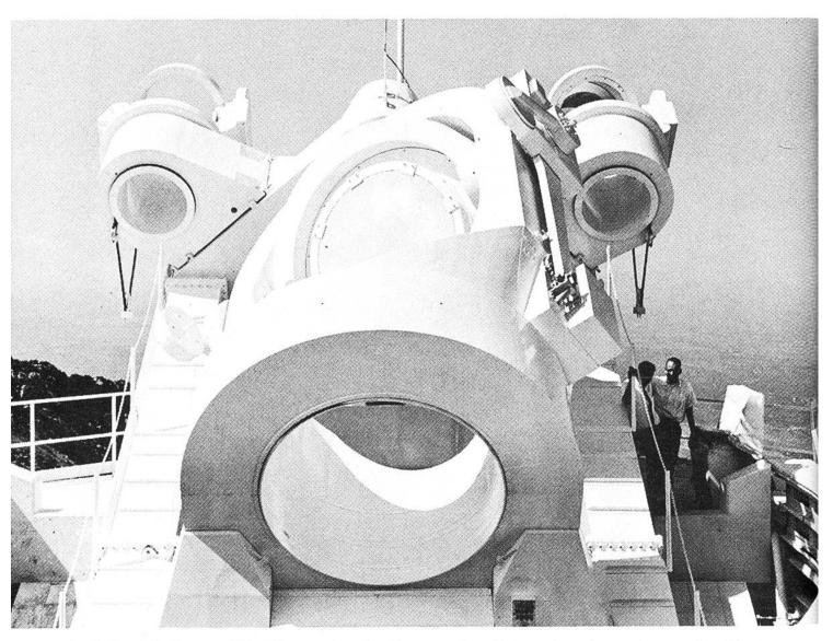
Auf der höchsten Plattform des Instruments stehend, erkennt man im Zentrum der Metallkonstruktion den grossen Planspiegel, der das Sonnenlicht einfängt.
