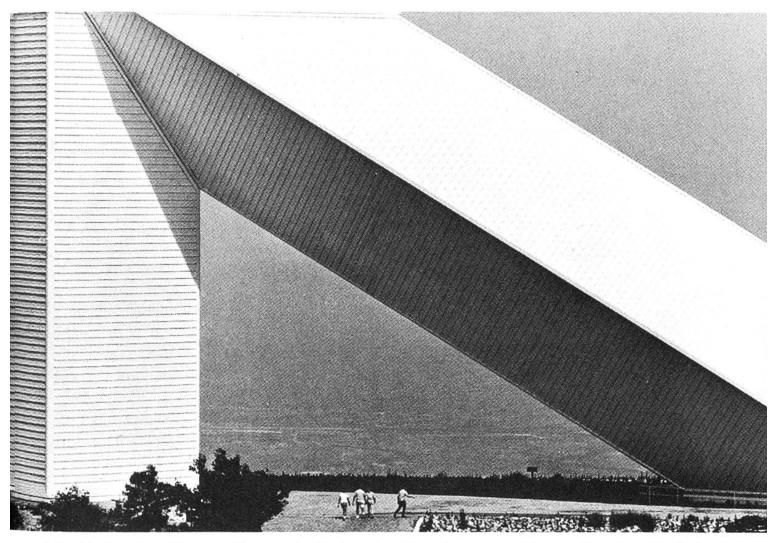
Alle Teile der Konstruktion sind blendend weiss gestrichen, damit möglichst viel Licht reflektiert wird und die Struktur nicht übermässig aufheizt.
