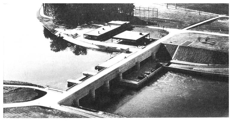
Mit der Erneuerung bestehender Wasserkraftwerke kann mehr Strom erzeugt werden. Beim Kraftwerk Bannwil wurde das alte Werk durch einen Neubau ersetzt. Die Erzeugung in einem Jahr mit durchschnittlicher Wasserführung konnte dadurch um 152 Prozent erhöht werden.
