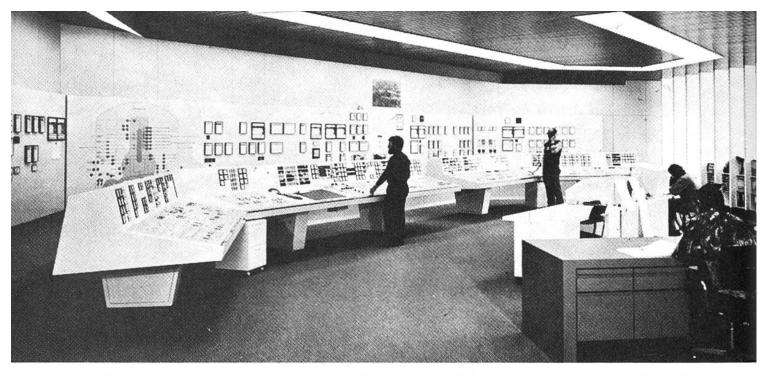
Der Kommandoraum des Kernkraftwerks Mühleberg, sozusagen das Hirn der Anlage. Die Operateure, die das Werk «fahren» (der Ausdruck für «steuern» in der Kraftwerk-Fachsprache), erhalten durch Kontrollampen, Messinstrumente und Computerausdrucke den Betriebszustand aller wichtigen Aggregate fortwährend gemeldet.
