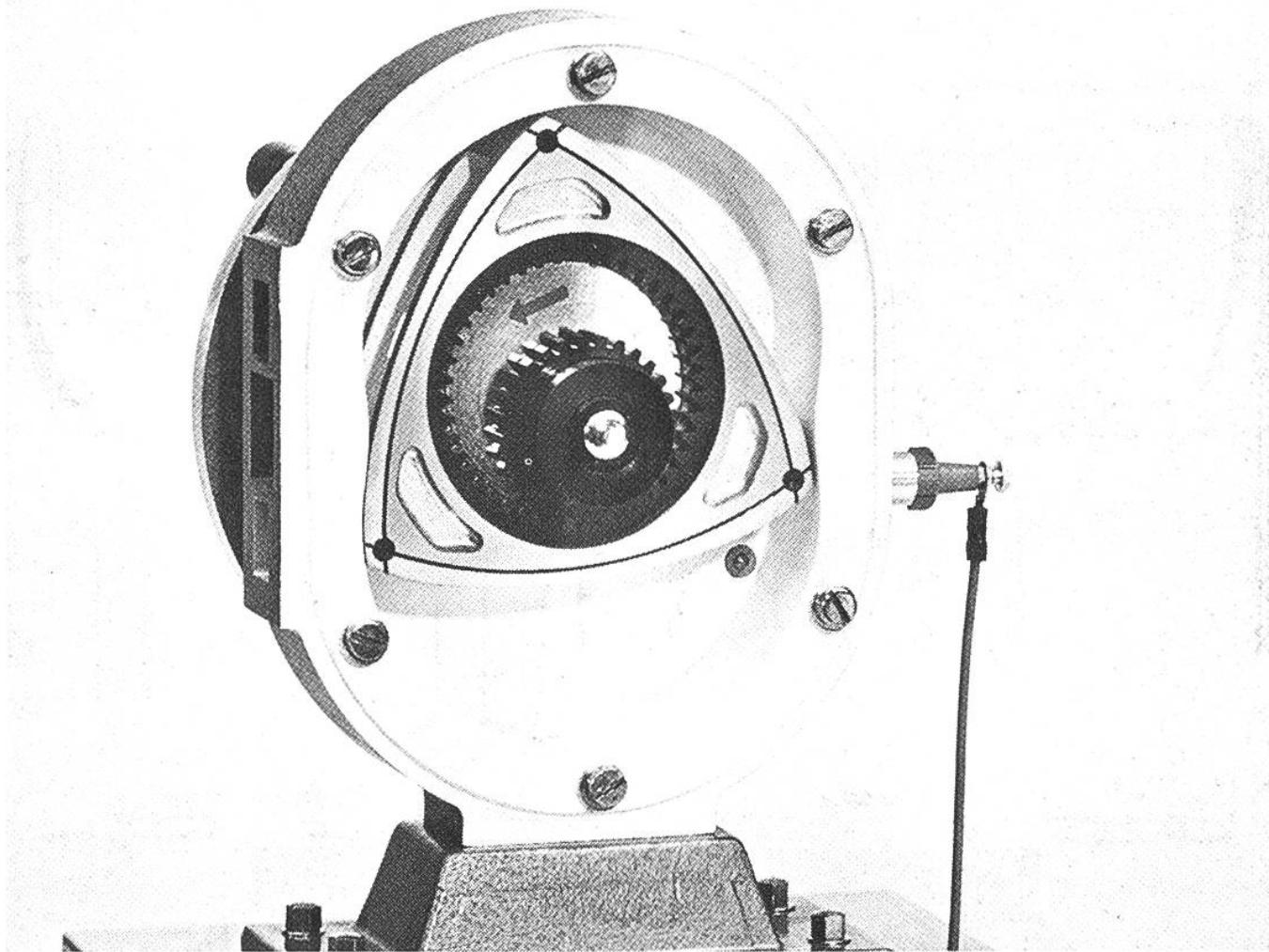
missen, sind die Ventile mit den zugehörigen komplizierten Gestängen und Hebeln, die Pleuelstangen, die Kurbel- und Nockenwelle. Der Wankel weist, und dies erscheint uns höchst bemerkenswert, nur noch zwei bewegte Teile auf – und beide vollführen eine Drehbewegung.
