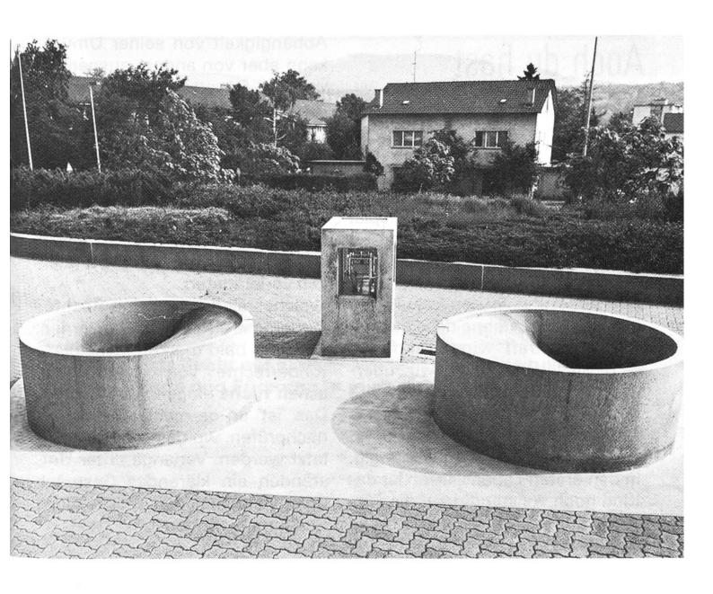
Steuerung (mittels einer besonderen «Kurvenscheibe» für jeden Mondmonat der nächsten 50 Jahre) eingerichtet werden. Sie befindet sich in einem Steuerungsgehäuse und reguliert den Wasserstand in einem als «Trommelregulator» ausgebildeten kommunizierenden Gefäss. — Der Mondbrunnen bildet also mit mechanischen Mitteln einen kosmischen Vorgang ab.
