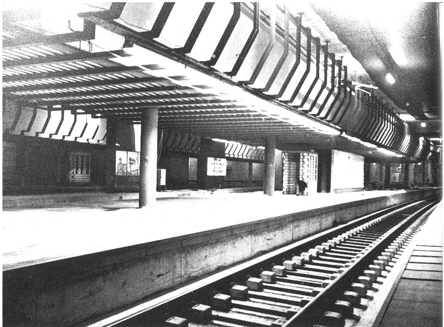
Der Bahnhof Zürich Flughafen im Rohbau. Unterirdische Perronhalle mit vier Gleisen.
