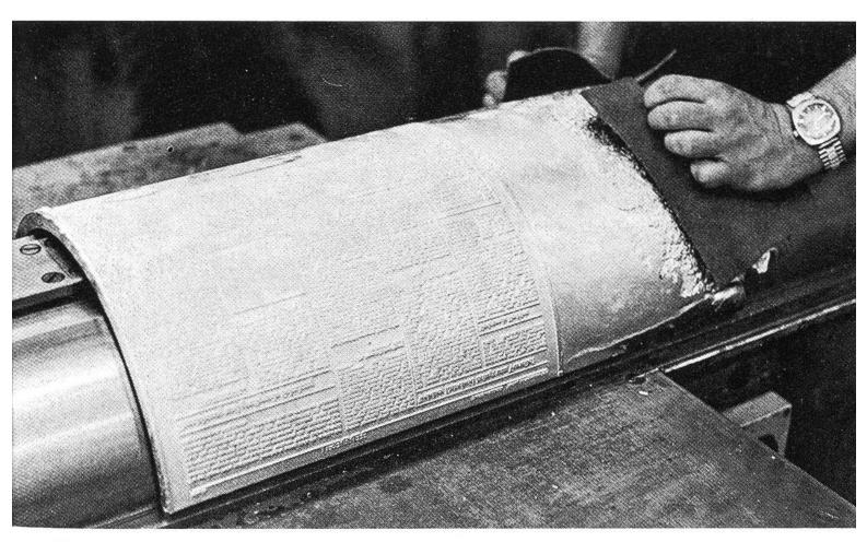
Bevor die mit Blei ausgegossenen Rundplatten auf die Rotationsmaschine gespannt werden, fräst man sie millimetergenau zurecht.
