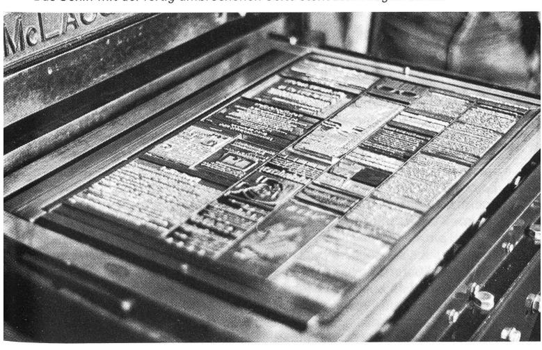
nen aufs Blei gepresst. Die Mater bog man in eine halbrunde Form und goss sie im Giessautomaten mit Blei aus. Dadurch entstanden halbrunde Platten, auf denen spiegelbildlich das Druckbild einer Zeitungsseite wiedergegeben war. Die fertigen Rundplatten spannte man schliesslich auf die Druckzylinder der Rotationsmaschine.
