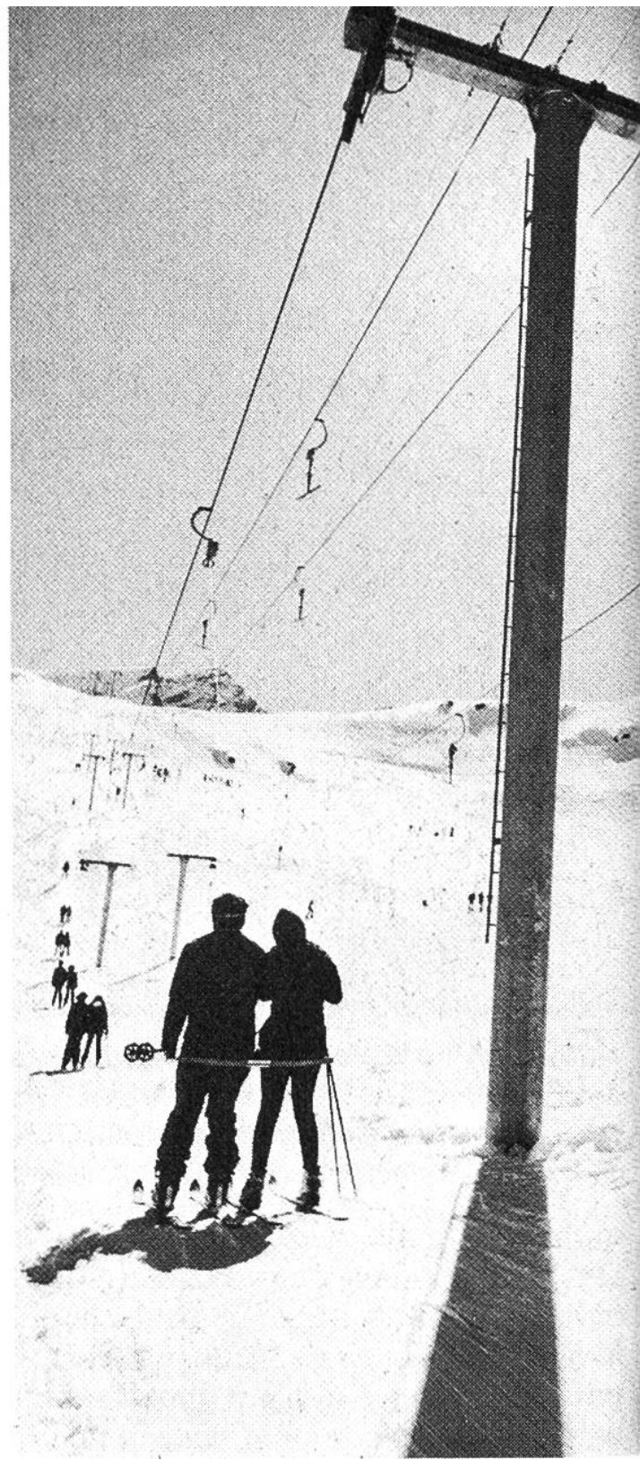
Parallel-Bügelseilbahn. Die talwärts fahrenden Gehänge schweben hoch in der Luft wieder der Anbügelstation entgegen (Sils/Furtschellas, Engadin).
