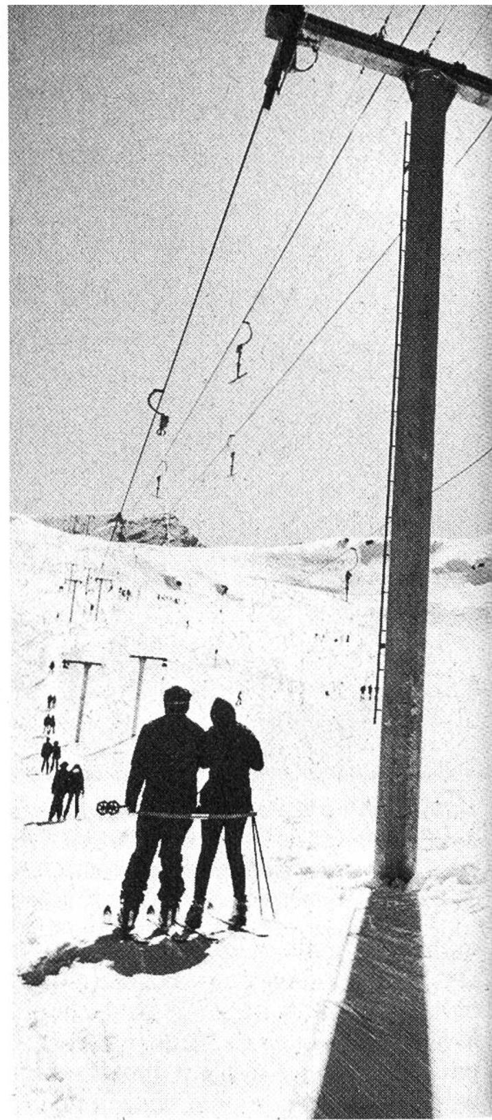
Parallel-Bügelskilift. Die talwärts fahrenden Gehänge schweben hoch in der Luft wieder der Anbügelstation entgegen (Sils/Furtschellas, Engadin).
