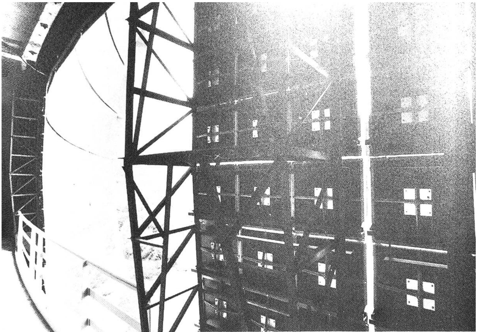
*Im Brennpunkt, 18 m vom Hohlspiegel entfernt und 13 m über dem Boden, erreicht die Sonnenenergie eine Wärme von knapp 4000 Grad Celsius. Im Sonnenofen (separater Turmbau) frisst sich die Wärmeenergie sekunden-schnell durch zentimeterdicke Stahlplatten.*
