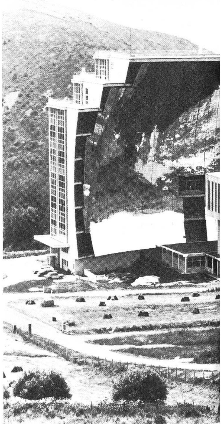
Im mehr oder weniger flachen Tal sind, dem Hohlspiegel gegenüber, in 130 m Entfernung flache Spiegel aufgestellt, sie fangen die Sonnenstrahlen ein und geben sie an den Parabolspiegel weiter.
