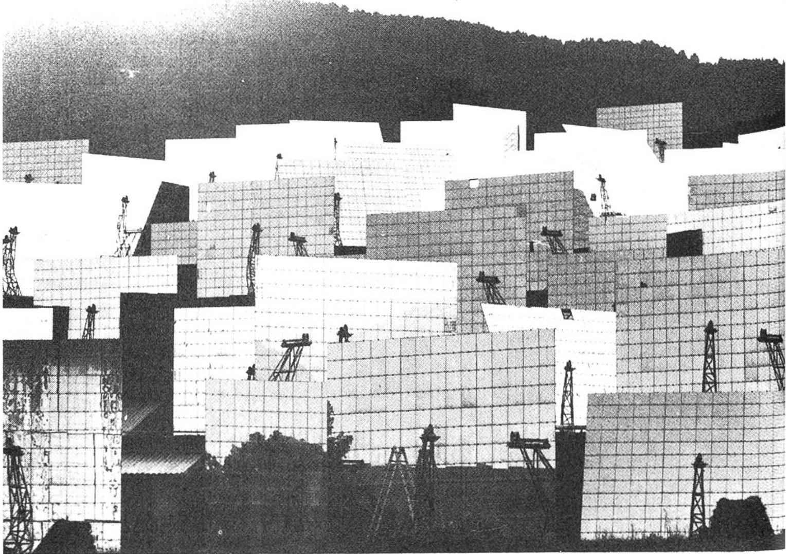
*Auf acht Terrassen angelegt, richten sich die 63 Planspiegel nach dem Stand der Sonne. Aus je 180 Elementen zum Ganzen gefügt, 45 m<sup>2</sup> gross, fängt jeder Planspiegel Sonnenlicht ein und reflektiert es auf den zentralen Hohlspiegel.*
