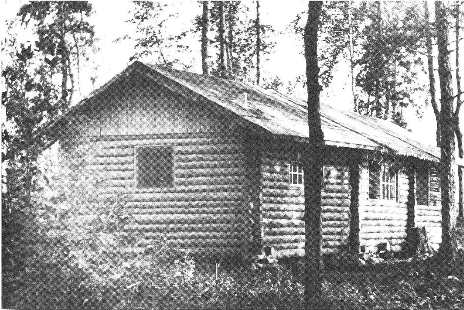
*Erst im zweiten Sommer wurde unser Blockhaus fertig. Das Dach ist mit Teerpappe gedeckt, die Fenster können im Sommer durch Moskitodrahtgitter ersetzt werden. Bretter für Dach, Fußboden und Möbel habe ich auf einer kleinen, selbstgebauten Sägemaschine geschnitten.*
