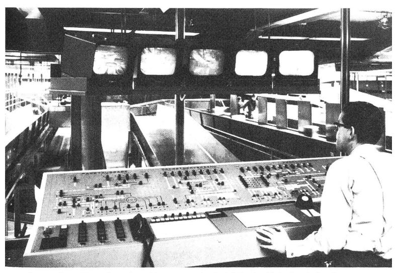
Fernsehen einmal anders. Der gesamte Betrieb der Paketverteilanlagen wird von einer zentralen Kommandostelle aus gesteuert und überwacht.
