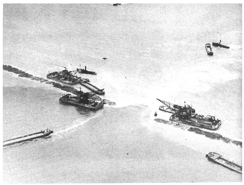
Der Bau von Deichen über ganze Meeresarme ist eine Spezialität der niederländischen Wasserbauingenieure. Die grösste Schwierigkeit bereitet stets das Schliessen der letzten Lücke im aufgeschütteten Fundament, weil dort mit kräftigen Strömungen zu kämpfen ist.
