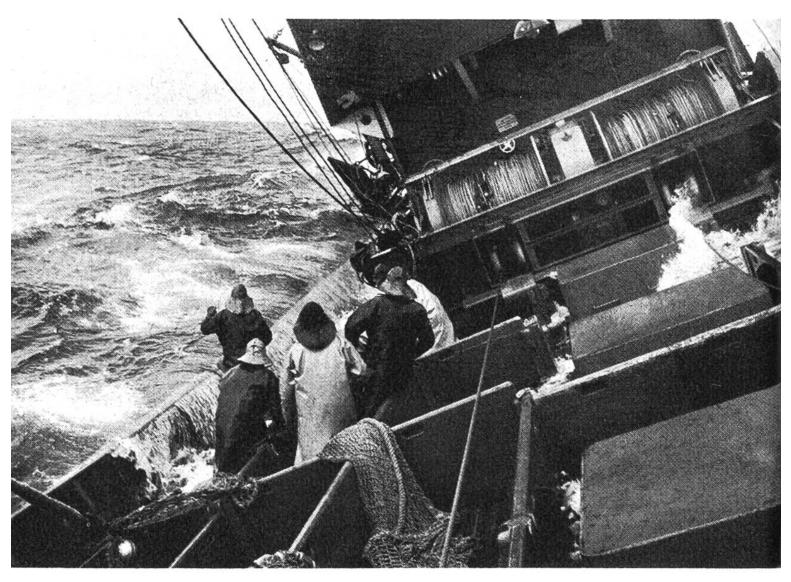
Bei rauher See wird das Grundschleppnetz mit den zentnerschweren Gleitrollen ausgesetzt. Bis zu 45 Grad neigt sich schon bei mässigem Seegang das Schiff nach Backbord und Steuerbord, und die Matrosen müssen schon tüchtige «Seebeine» haben, um ihre harte Arbeit zu verrichten.
