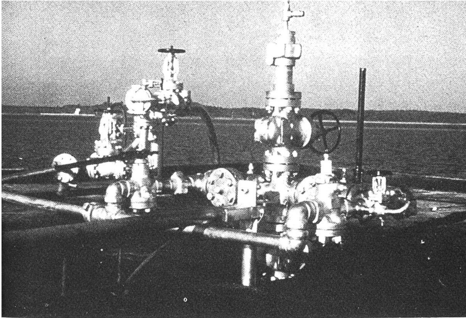
*Das Öl ist gefunden. Aus dem Bohrloch wird der sogenannte «Weihnachtsbaum», eine Sicherheitsanlage mit Ventilen und Schiebern, eingebaut, mit der der Ölfluss kontrolliert werden kann. Von der fest installierten Plattform fliesst das Öl ans Ufer. Die Plattform befindet sich im Golf von Biskaya.*
