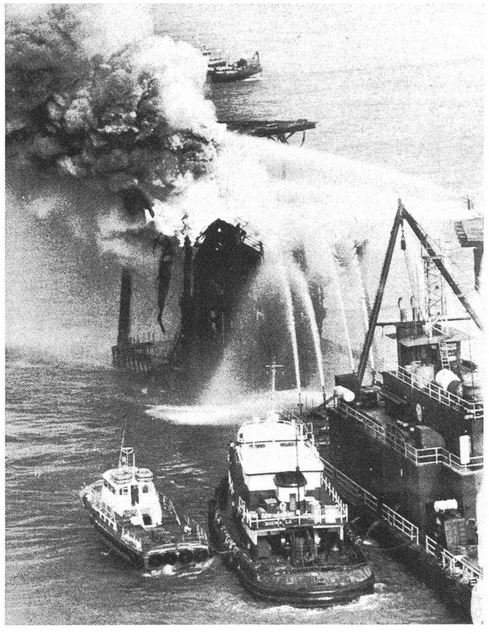
Einer der an sich seltenen Brandausbrüche und wohl einer der schwersten ereignete sich im Februar 1970 im Golf von Mexiko. Da der Zufluss vom eben gefundenen Öl nicht gestoppt werden konnte, erhielt das Feuer immer neue Nahrung. Die Eisenkonstruktion der Plattform schmolz und brach schliesslich in sich zusammen.
