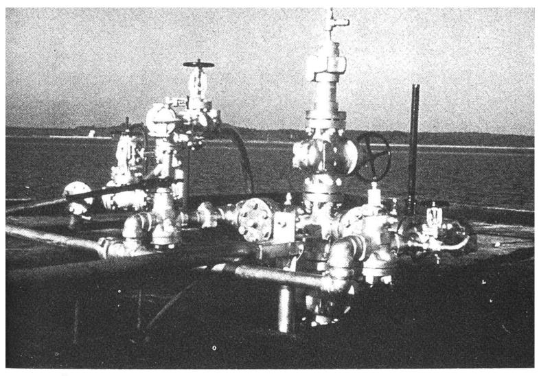
Das Öl ist gefunden. Aus dem Bohrloch wird der sogenannte «Weihnachtsbaum», eine Sicherheitsanlage mit Ventilen und Schiebern, eingebaut, mit der der Ölfluss kontrolliert werden kann. Von der fest installierten Plattform fliesst das Öl ans Ufer. Die Plattform befindet sich im Golf von Biskaya.
