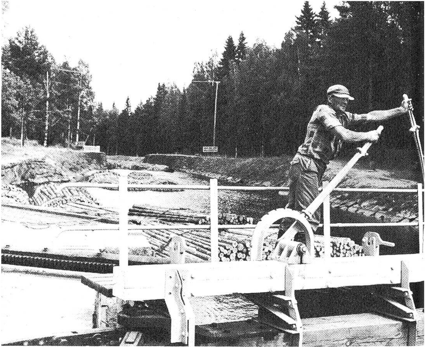
Ganze Pakete von Stämmen, mit schweren Ketten verschnürt, gleiten hier langsam durch einen Kanal. Indem er die verschiedenen Schleusentore öffnet oder schliesst, sorgt der Schleusenwart für reibungslosen Transport.
