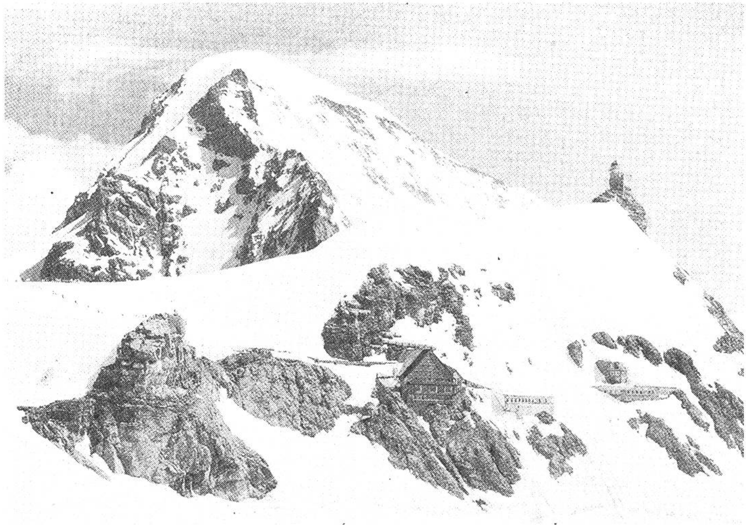
Blick von Süden gegen das Jungfrauoch und den Mönch. Die Gebäude von links nach rechts sind das Hotel Berghaus, das Touristenhaus, die Hochalpine Forschungsstation und, auf dem Sphinx-Felsen, das Sphinx-Observatorium.
