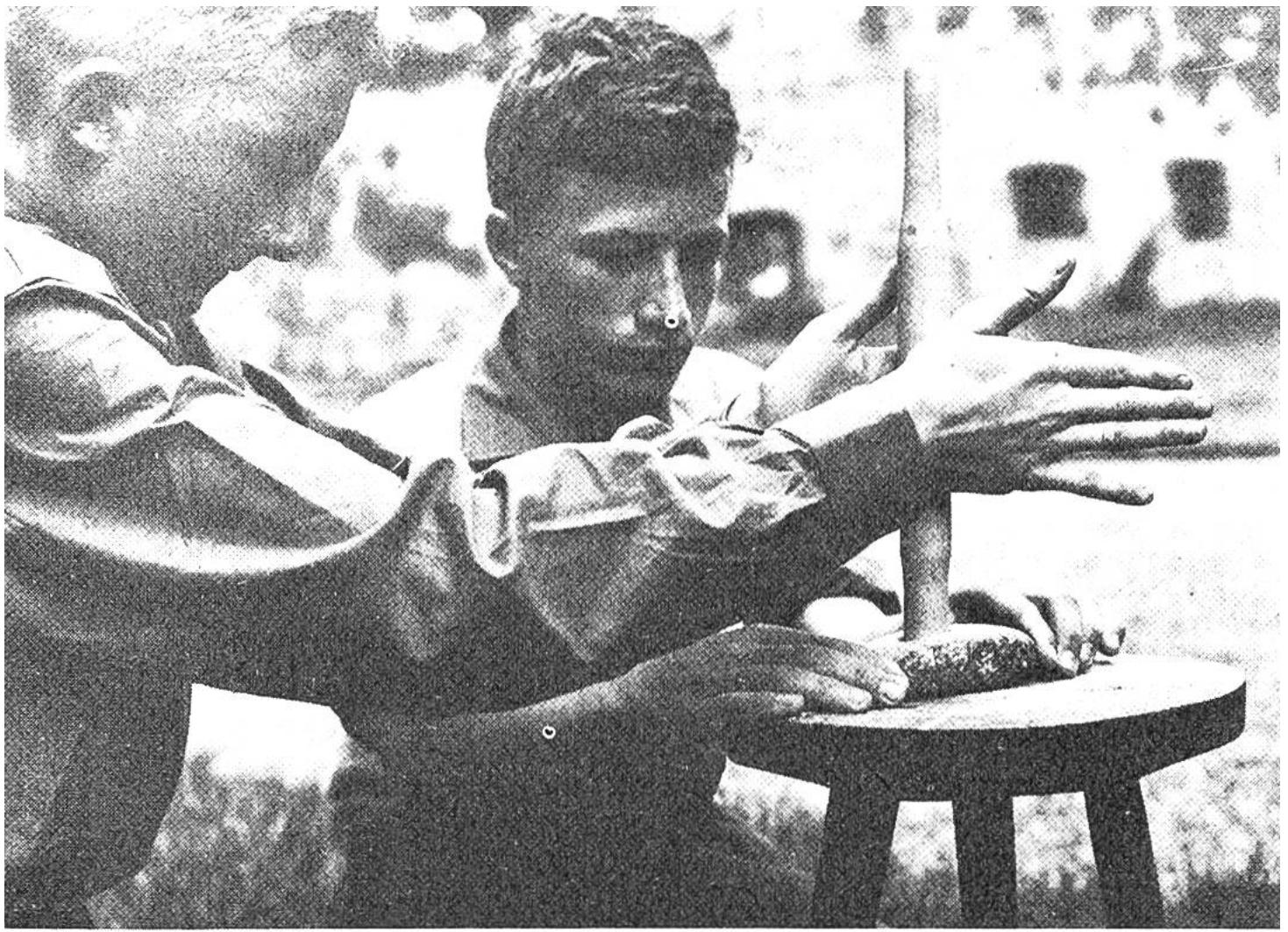
*Unser Hohlbohrer ist ein Holunderstab, geschält und ohne Mark. Nach wenigen Stunden bildet sich eine kreisförmige Rille. Holunder gehört zu den Harthölzern: Der Bohrer nützt sich so schwach ab, dass er für mehrere Bohrungen verwendet werden kann.*
