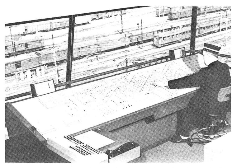
Dies ist der Fahrdienstleiter des Stelltisches Nr.1 mit weit über 1000 Tasten. Durch Drücken zweier Tasten stellt er soeben eine «Fahrstrasse» ein. Innert Sekunden stehen alle Weichen und Signale so, dass der Zug diese «Strasse» ohne jegliche Gefährdung durch andere Züge befahren kann.
