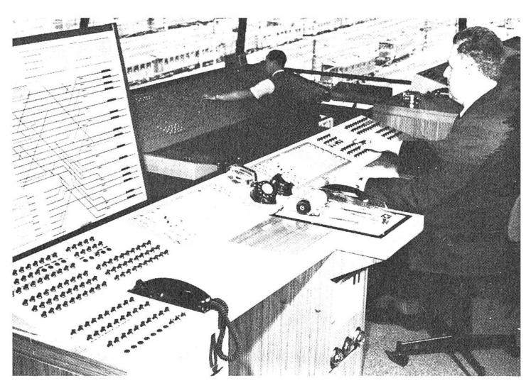
Der Bahnhofüberwacher (im Vordergrund) leitet das ganze Betriebsgeschehen und gibt den Fahrdienstleitern Anordnungen. Der Arbeitsplatz ist durch Wechselsprech- und Funkverbindungen mit allen wichtigen Stellen des Bahnhofs verbunden. Links die grosse Meldetafel.
