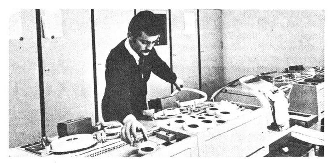
Von den Lochstreifengeräten wird der zu setzende Text in den Computer eingelesen und von diesem verarbeitet.
