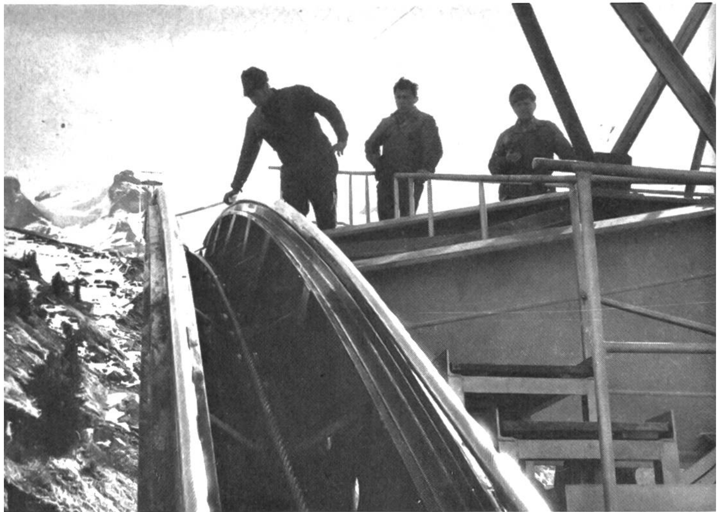
Seilkontrolle von Hand auf einem Mast.
