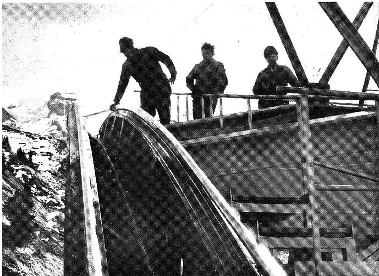
Seilkontrolle von Hand auf einem Mast.
