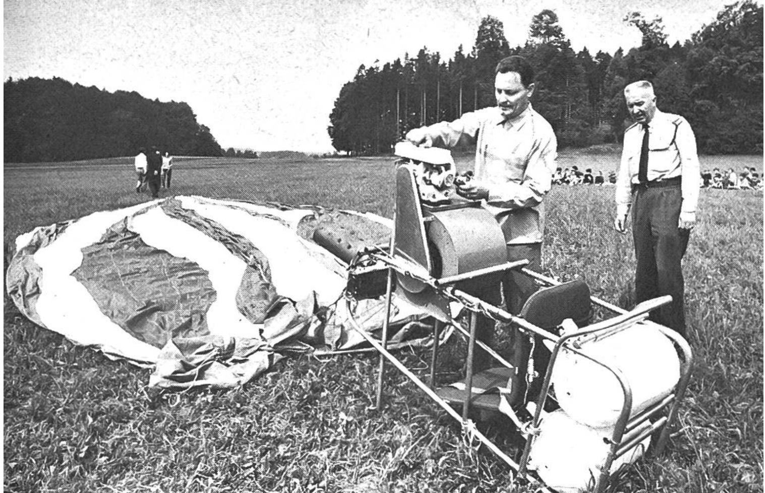
Der Feuerstuhl ist umgekippt und mit der Ballonhülle fest verkuppelt. Der Ventilator, der auf dem Stuhl steht, füllt die Hülle in wenigen Minuten mit Luft. Dann erst wird der Brenner in Funktion gesetzt, um die Luft zu erhitzen. Dann hebt sich die Hülle und stellt gleichzeitig den Stuhl auf, so dass der Ventilator entfernt werden kann und der Pilot aufsitzen kann. Nach einigen weiteren Minuten ist die Temperatur im Ballon dann so erhöht, dass der Ballon abheben kann.
