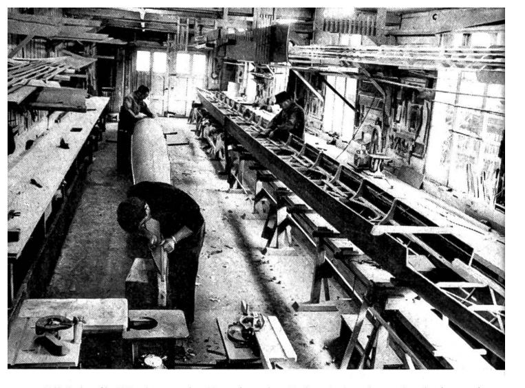
Blick in die Werkstatt des Bootbauers: Beim Achterboot (rechts) werden eben die Schienen für die Rollsitze montiert, beim Vierer (links) bringt man die hauchdünne Bootsschale auf.
