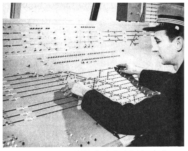
Modernes elektrisches Gleisbildstellwerk. Durch Drücken der Tasten «Ausgangsort» und «Ziel» der Fahrt laufen die Weichen des gewünschten Fahrweges automatisch in die richtige Lage.
