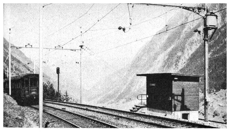
Blockstelle Eggwald, zwischen Wassen und Göschenen, mit automatischen Signalen und Achszählapparaten (Detail im Bild unten).
