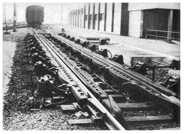
In Rangierbahnhöfen werden die abrollenden Wagen durch Geleisebremsen auf eine bestimmte Geschwindigkeit gebremst. Neuerdings ist auch automatische Steuerung möglich.
