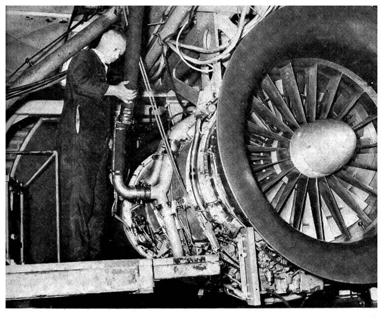
Geübte Spezialisten schliessen das Triebwerk an die Energiequellen und Messgeräte des Prüfstandes an.
