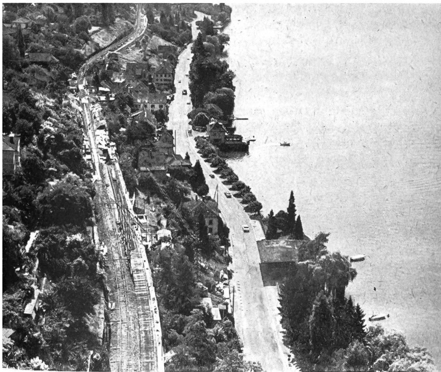
Zwischen Erlenbach und Herrliberg/Feldmeilen, an der Seehalde, wird ein Lehnenviadukt gebaut, damit ein zweites Geleise gelegt werden kann.
