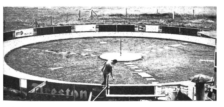
Das ist eine der Rennbahnen für Modellautos in der Schweiz. Der Durchmesser der Rennbahn – eines Betonringes – beträgt 19,9 Meter.
