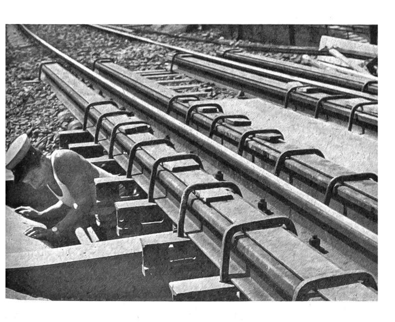
Die Geleise werden an Schienenbündeln aufgehängt, damit darunter die Brücke erstellt werden kann. Der Zugsverkehr darf eben nicht unterbrochen werden.
