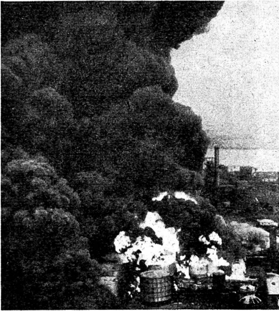
Gewaltiger Brand in der Tankfarm einer Raffinerie.
