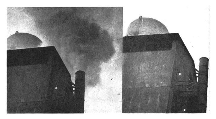
Die Wirkung von Luftreinigungsanlagen in der Industrie. Links: vor Einbau der Filteranlage; rechts: nach Einbau.
