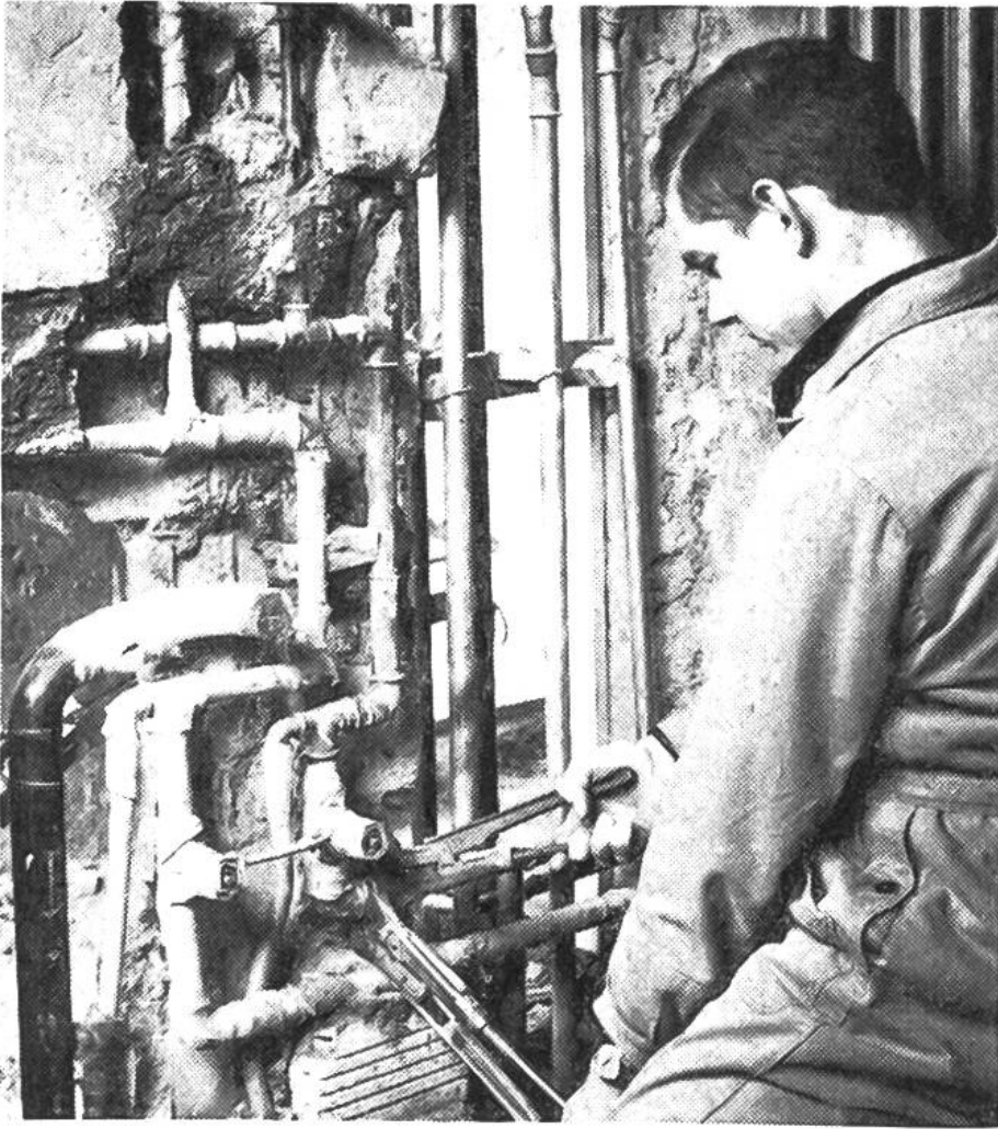
Ein Labyrinth von Leitungen vor dem Zumauern.
