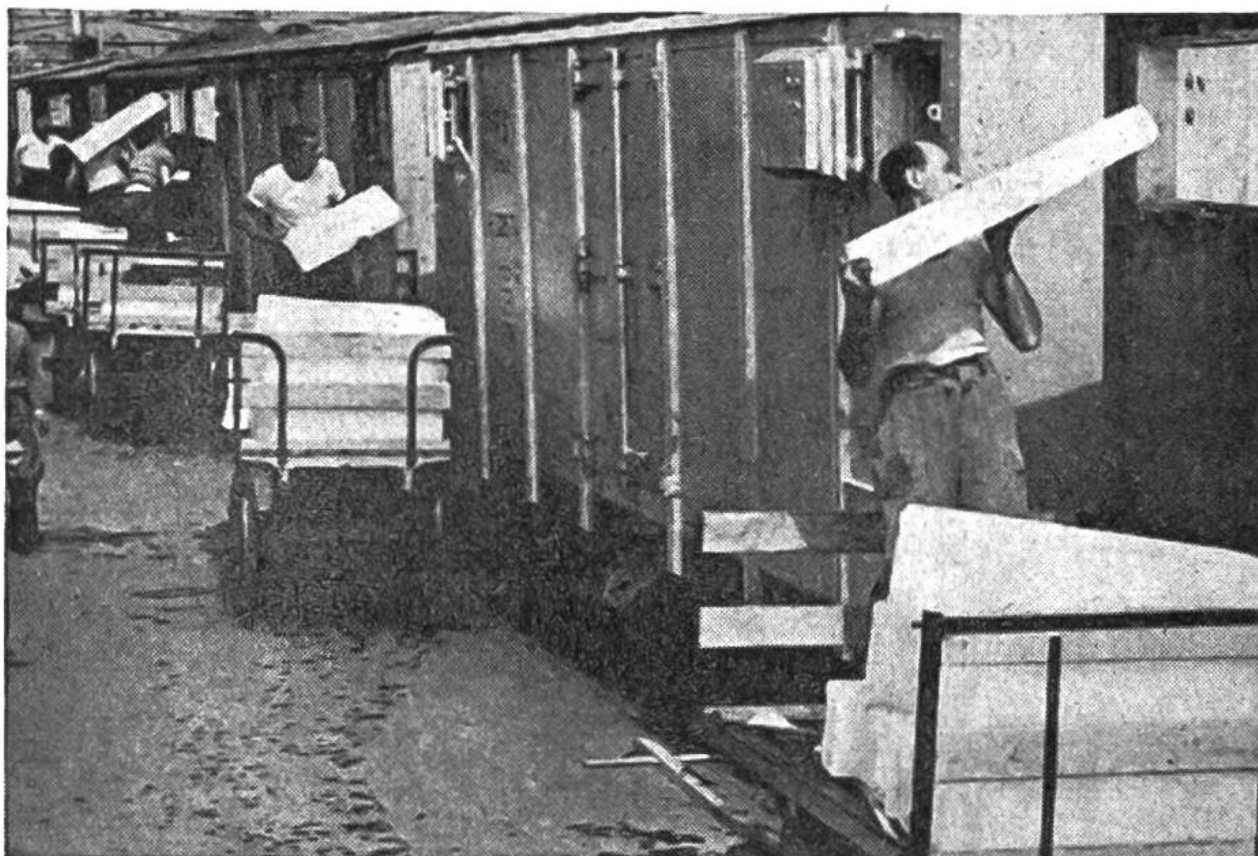
Die Kühlwagen eines Eisenbahnzuges werden für den Transport leicht verderblicher Lebensmittel mit künstlichem Eis versorgt. Heute verfügen die meisten Kühlwagen über Kältemaschinen oder werden mit sogenanntem Trockeneis (gefrorene Kohlensäure) oder mit flüssiger Luft gekühlt.
