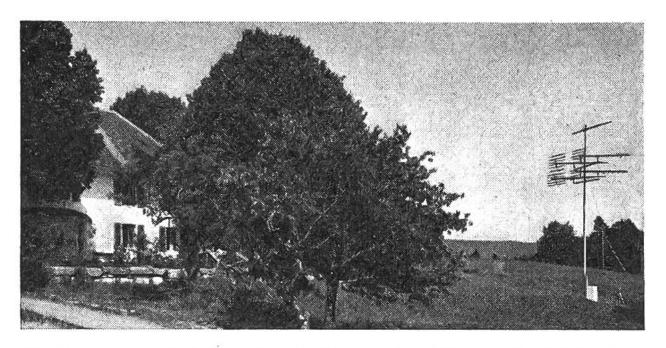
Die Antenne des Drahtfernsehens in Biel steht in erhöhter und störfreier Lage in ländlicher Umgebung und vermittelt deshalb sehr guten Empfang.
