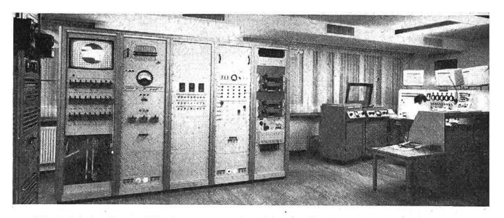
Ein Blick in die Rediffusionszentrale in Biel, wo die Verstärker- und Kontrollapparate für den Niederfrequenz-Drahtrundspruch (beim Studiopult), den Hochfrequenzrundspruch und das Drahtfernsehen untergebracht sind.
