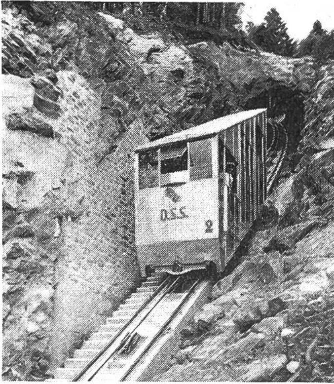
Bei der Standseilbahn Schwyz-Stoos, einer der steilsten in Europa, besteht das Gerippe aus der Legierung «Anticorodal», die Verschalung aus der Legierung «Aluman». Ein Wagen wiegt 2150 kg, wovon 890 kg Leichtmetallteile sind.
