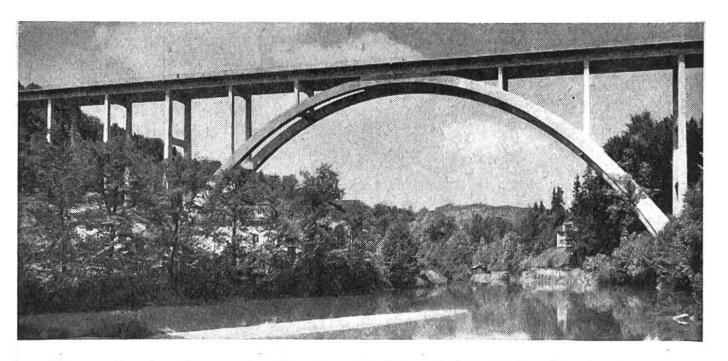
Kräzernbrücke, Strassenbrücke über die Sitter bei St. Gallen in Eisenbeton. Spannweite des Bogens 135 m.
