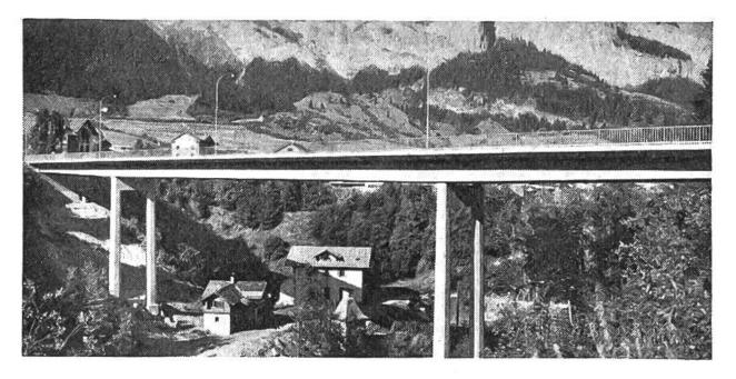
Stennabrücke in Flims. Strassenbrücke in Vorspannbeton, totale Länge 111 m, grösste Spannweite 58 m, Baujahr 1959. Vorspannbeton: Eingelegte Stahlkabel, welche beim Bauvorgang gespannt werden, setzen den Beton überall so unter Druck, dass auch bei Belastung keine Zugspannungen auftreten können.
