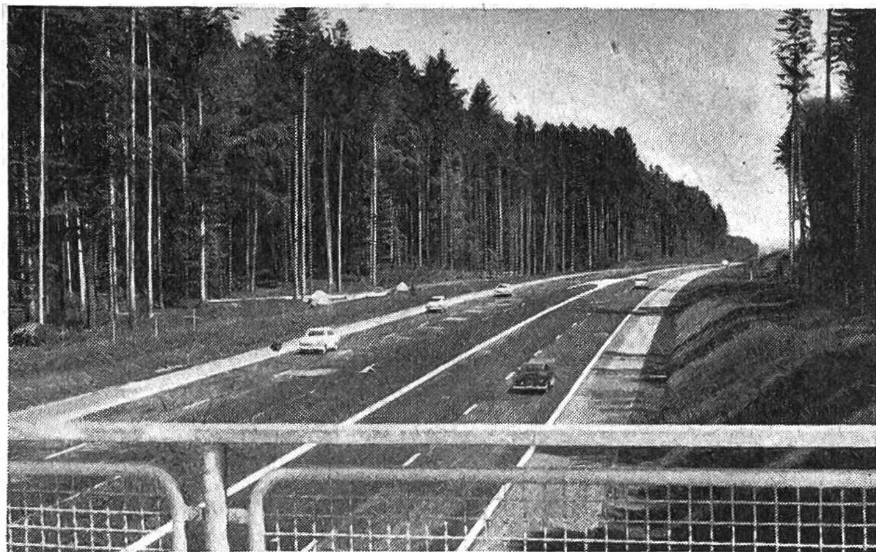
Nationalstrasse N 1. Grauholzstrasse im Betrieb.
