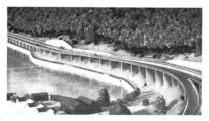
Aufnahme eines Modells der Nationalstrasse N 2, Abschnitt Hergiswil-Lopper. Solche Modelle werden bei schwierigem Gelände als Ergänzung zu den Projektplänen angefertigt.
