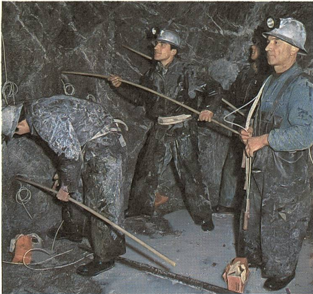
Mineure beim Einführen der Sprengladung.
