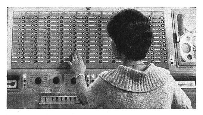
Im Verstärkeramt werden die Radiostudio-Leitungen auf die Sender und das Telephonrundspruchnetz geschaltet.
