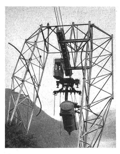
Schwerlastseilbahn Biasca (Blenio-Kraftwerke) mit 12-Tonnen-Zementbehälter.
