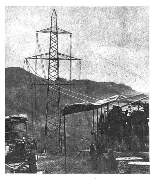
Die Vorseile für den Seilzug sind mit der links im Bild sichtbaren Seilwinde ausgelegt worden. Über die am Mastausleger sichtbaren Seilrollen werden nun die schweren (im Bild von rechts kommend) sichtbaren Leiterseile ausgelegt. Der Zug erfolgt von einer um einen Seilzugabschnitt entfernt aufgestellten grossen Seilzugmaschine. Die auf dem Bild rechts sichtbare Seilbremsmaschine sorgt dafür, dass ein gewisser Seilzug aufrechterhalten wird.
