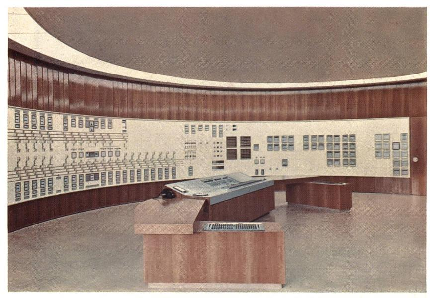
Kommandoraum eines modernen Kraftwerkes. Von hier aus wird der Betrieb der Generatoren, der hydraulischen Maschinen und Apparate gesteuert und die Freiluftschaltstation bedient.
