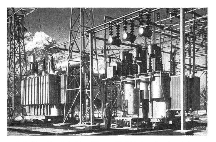
Freiluft-Transformatorenstation Wimmis der Bernischen Kraftwerke AG, Bern. Dreiwicklungs-Stufentransformator für 20000 kVA, mit angebautem Stufenschalter für 150 kV. Rechts: Dreiphasentransformator für 25000 kVA mit Stufenschalter 65 kV.
