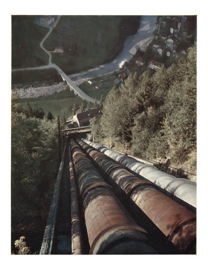
Hochdruck-Kraftwerk Amsteg. Im Vordergrund Druckleitungen, auf dem Talboden Maschinenhaus, im Hintergrund die Reuss, in die durch den Unterwasserkanal das genutzte Wasser fliesst.
