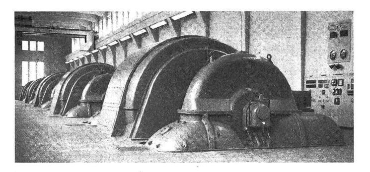
Maschinensaal des Kraftwerkes Riddes (links anschliessend an Bild 2) mit 5 kombinierten Maschinengruppen. Im Vordergrund Peltonturbine, daran anschliessend Synchrongenerator zur Elektrizitätserzeugung. Rechts Schalttafelfeld mit Überwachungsinstrumenten.
