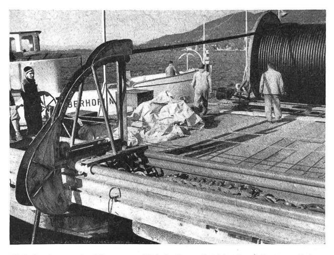
Kabelauslegung im Thunersee: Kabelrolle und Ablaufvorrichtung auf dem Verlegefloss, das vom Begleitschiff von Ufer zu Ufer gezogen wird.
