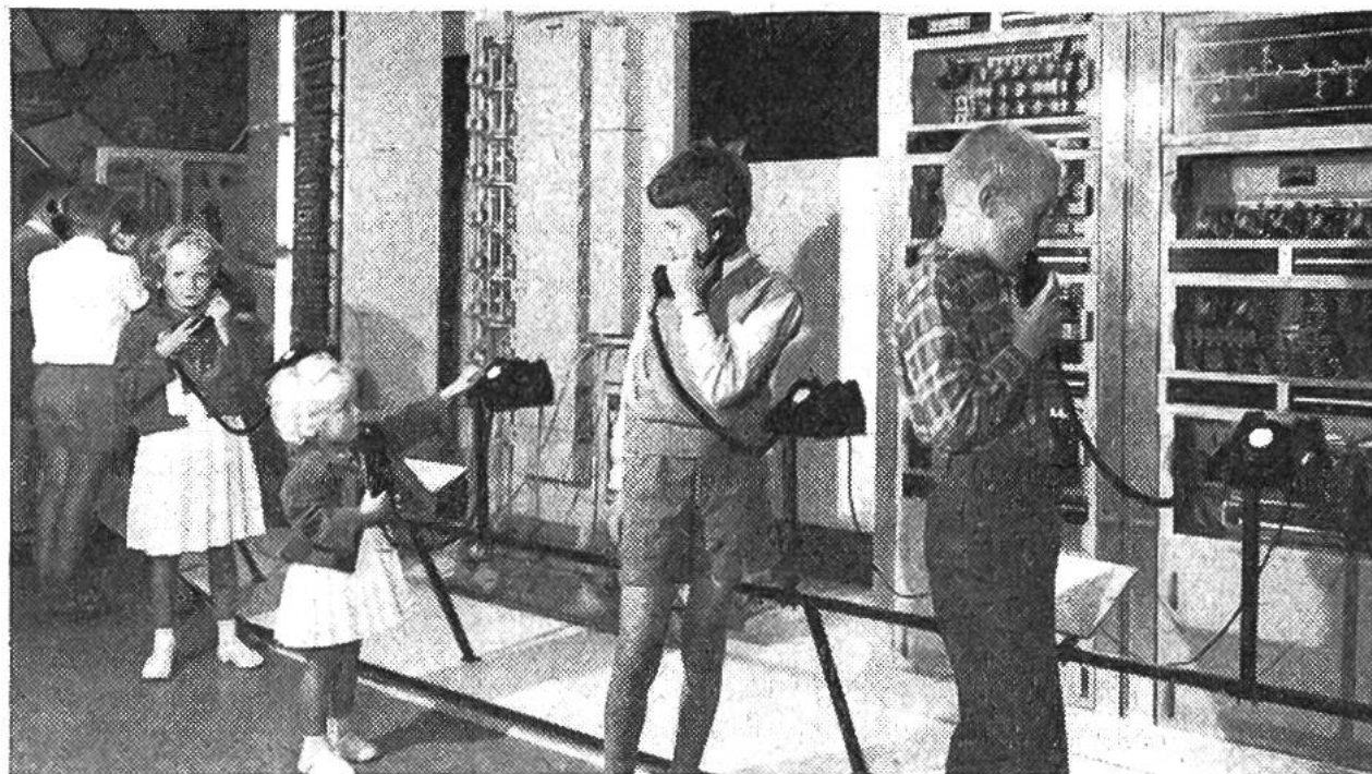
Eine richtiggehende automatische Telephonzentrale stellt die Verbindungen mit der sprechenden Uhr, dem Wetterdienst, dem Nachrichtendienst, den Sportmeldungen und den Strassenzustandsmeldungen der PTT her.
