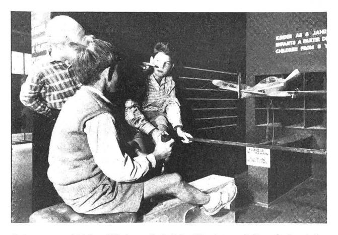
Bei grossen und kleinen Kindern sehr beliebt: Simulator mit Steuerknüppel, der auf Höhen- und Seitensteuer des in einem künstlichen Luftstrom schwebenden Flugzeugmodells einwirkt und alle Steuerungsmanöver ermöglicht.
