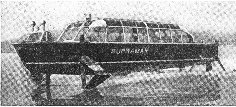
Das Supramar PT 10 versah den ersten regelmässigen Tragflügelboot-Passagierverkehr der Welt 1953/54 auf dem Langensee.
