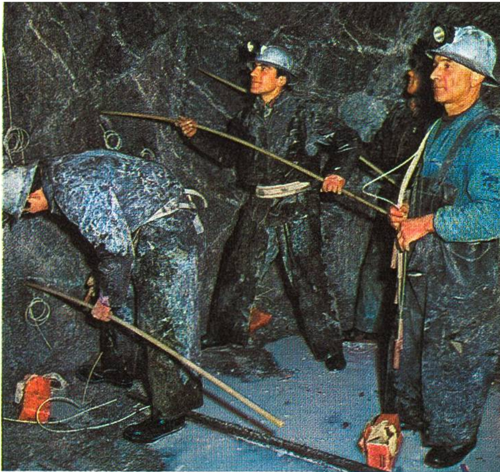
Mineure beim Einführen der Sprengladung.
