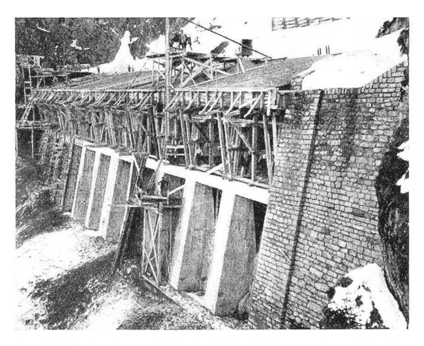
Die BLS-Gebirgsstrecke ist durch zahlreiche Schutzbauten und Aufforstungen gegen Lawinen, Felssturz, Steinschlag, Rutschungen und Wildwasser gesichert, so in der Lonzaschlucht (Lötschental) durch 9 Schutzgalerien von total 761 m Länge. Hier der Bau einer solchen Schutzgalerie.
