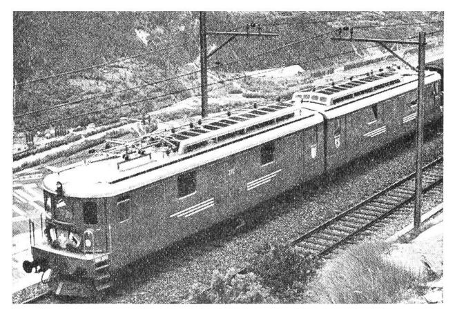
Dem Schnellzugs- und besonders dem Schwergüterverkehr der BLS dienen seit 1959 Doppellokomotiven (Ae 8/8), die mit 8800 PS eine Anhängelast von 900 Tonnen auf  $27^{\,0}/_{00}$  Steigung mit 75 km/h zu befördern vermögen. Sie sind ca. 30 m lang und 160 t schwer. – Südrampe, Blick ins Rhonetal (siehe S. 227).
