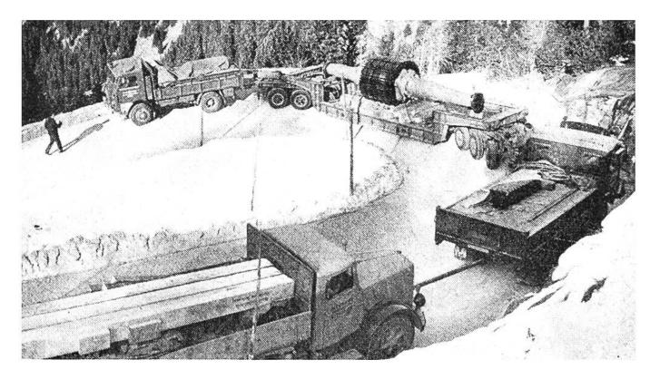
Rotor von 60 Tonnen wird über den Malojapass zum Kraftwerk Albigna gebracht.
