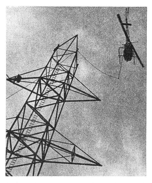
Beim Bau einer Hochspannungsleitung werden zuerst die Masten aufgebaut; anschliessend erfolgt der Seilzug, das Auslegen und Abspannen der den elektrischen Strom führenden Leiterseile aus Stahl-Aluminium oder Aldrey. Das Bild zeigt das Auslegen eines «Vorseiles» mittels eines Helikopters von Mast zu Mast, mit dem dann das «Zugseil» für den Nachzug der definitiven Leiterseile nachgezogen wird.
