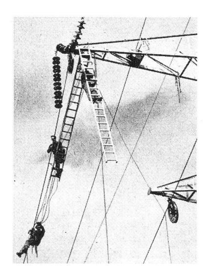
Nach erfolgtem Seilzug werden die Ausleger «ausgerüstet», d.h. die Isolatoren montiert und die Seildurchhänge einreguliert; eine gefahrvolle, Geschick und Mut erfordernde Arbeit viele Meter über dem Erdboden.
